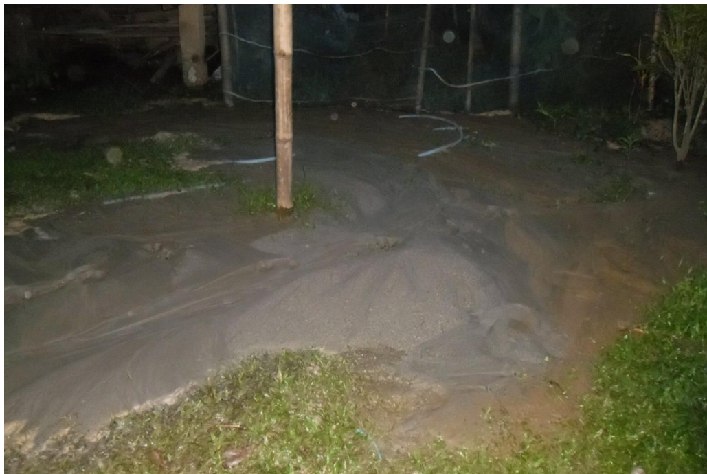
รูปที่ 6-14 การเกิด Liquefaction บริเวณผิวดินที่หลุมเจาะ BH-10
