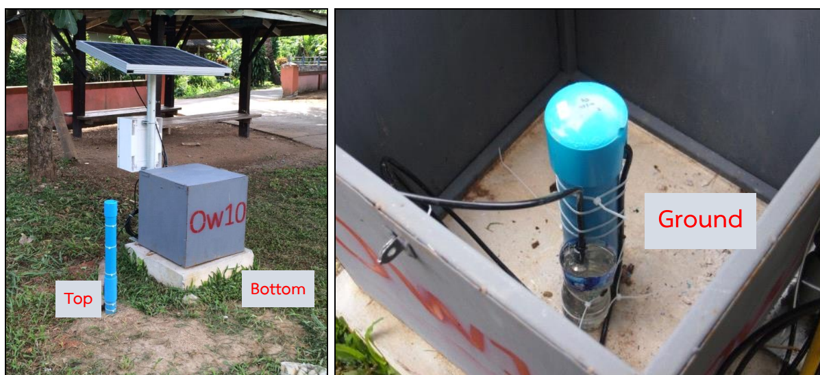
รูปที่ 4-2 หลุมวัดน้ำแบบ real time ณ หลุมเจาะ BH-10
