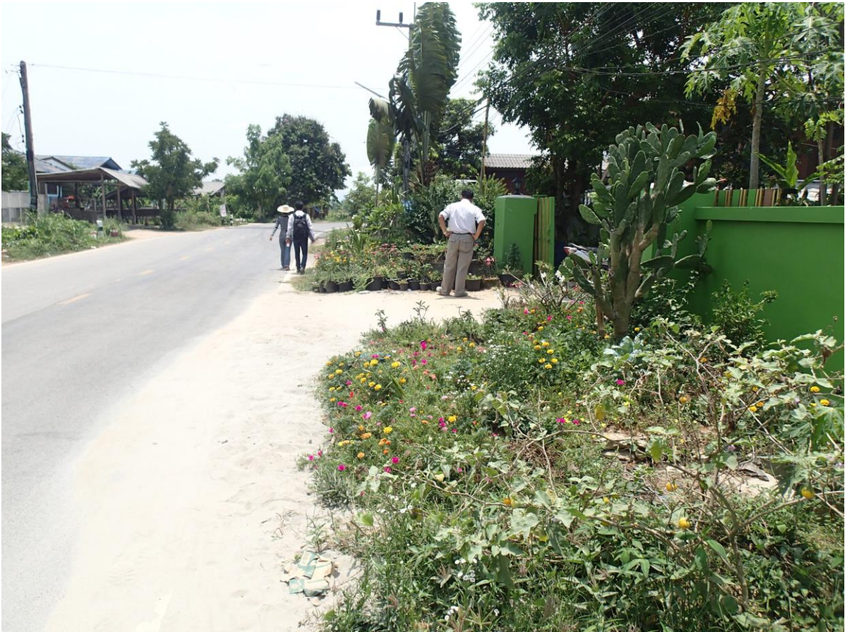
รูปที่ 2-10 การเกิด Liquefaction ที่บ้านสันกันแฮว ต.จอมหมอกแก้ว อำเภอแม่ลาว จังหวัดเชียงราย
