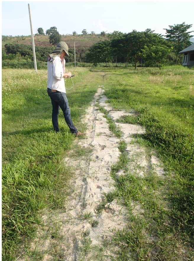
รูปที่ 6-13 การเกิด Liquefaction บริเวณผิวดินที่หลุมเจาะ BH-9
