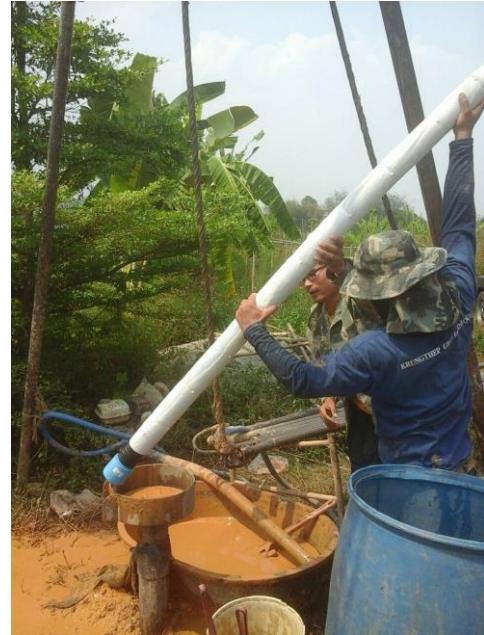
ปิดฝาท่อและพันรอบด้วย Geotextile แล้วหย่อนลงในหลุมเจาะ
