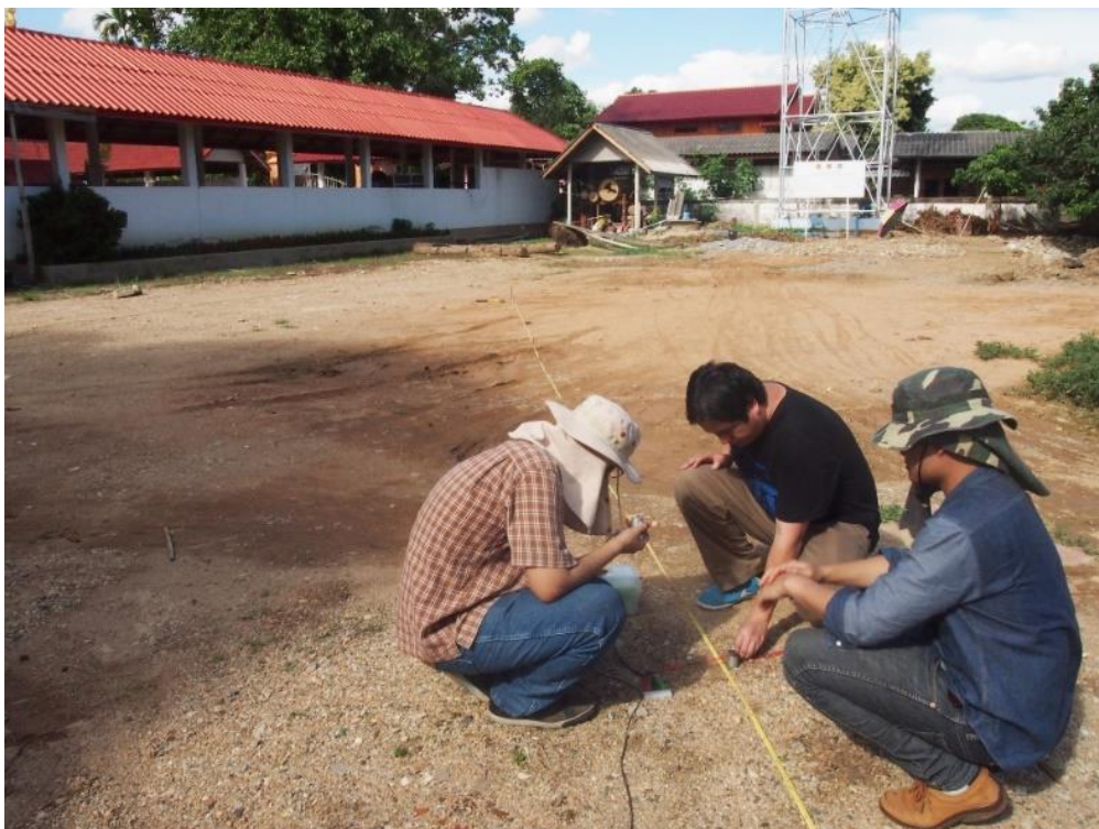
รูปที่ 5-15 ภาพถ่ายภาพการทดสอบ SASW บริเวณวัดน้ำล้อม
