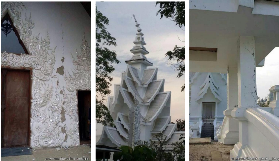
รูปที่ 8-1 ความเสียหายเนื่องจากแผ่นดินไหวที่วัดร่องขุน (สืบค้นจาก sanook.com และ kapook.com, 2557)
