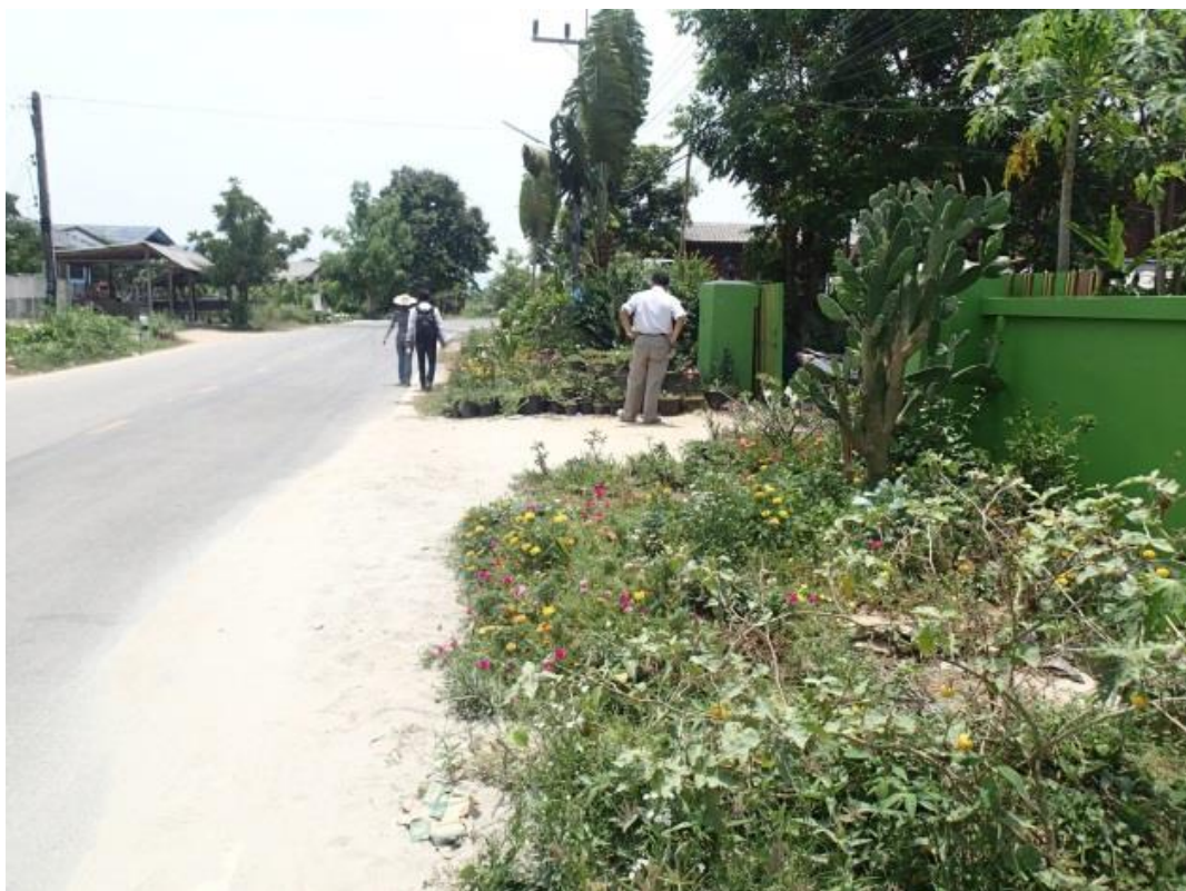
รูปที่ 6-12 การเกิด Liquefaction บริเวณผิวดินที่หลุมเจาะ BH-6
