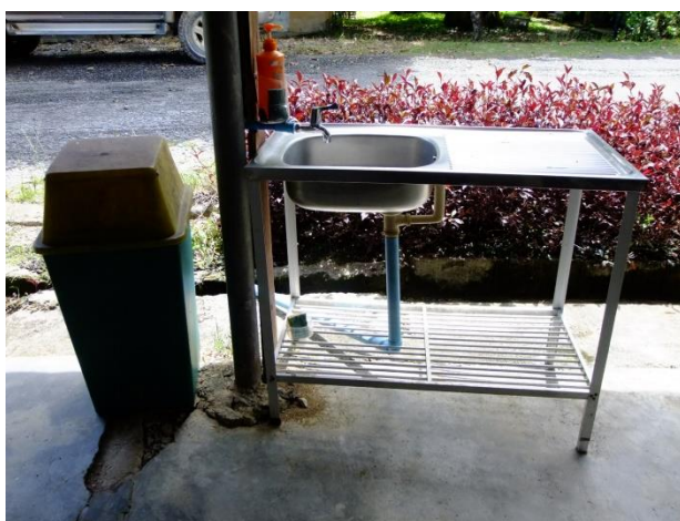
ถังขยะบริเวณร้านอาหารชุมชน
