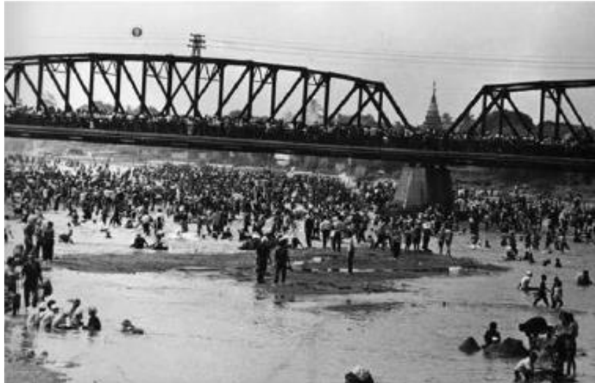
ภาพที่ 2.21 ชั่วเหล็ก สร้างด้วยโครงเหล็กบนตอม่อคอนกรีตเสริมเหล็ก
