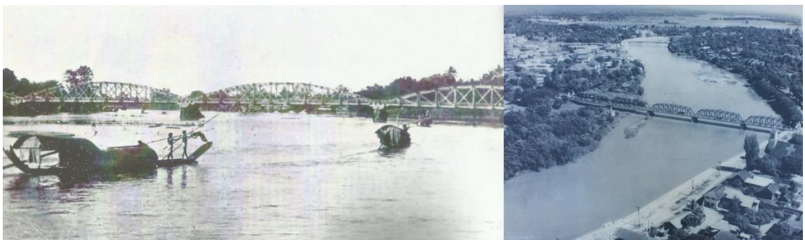
ภาพที่ 2.20 ภาพสะพานนวรัฐในอดีต
