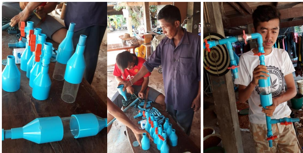
ภาพ 38-40 การออกแบบและอุปกรณ์ทดลองชุดกำจัดก๊าซไฮโดรเจนซัลไฟด์ในก๊าซชีวภาพ
