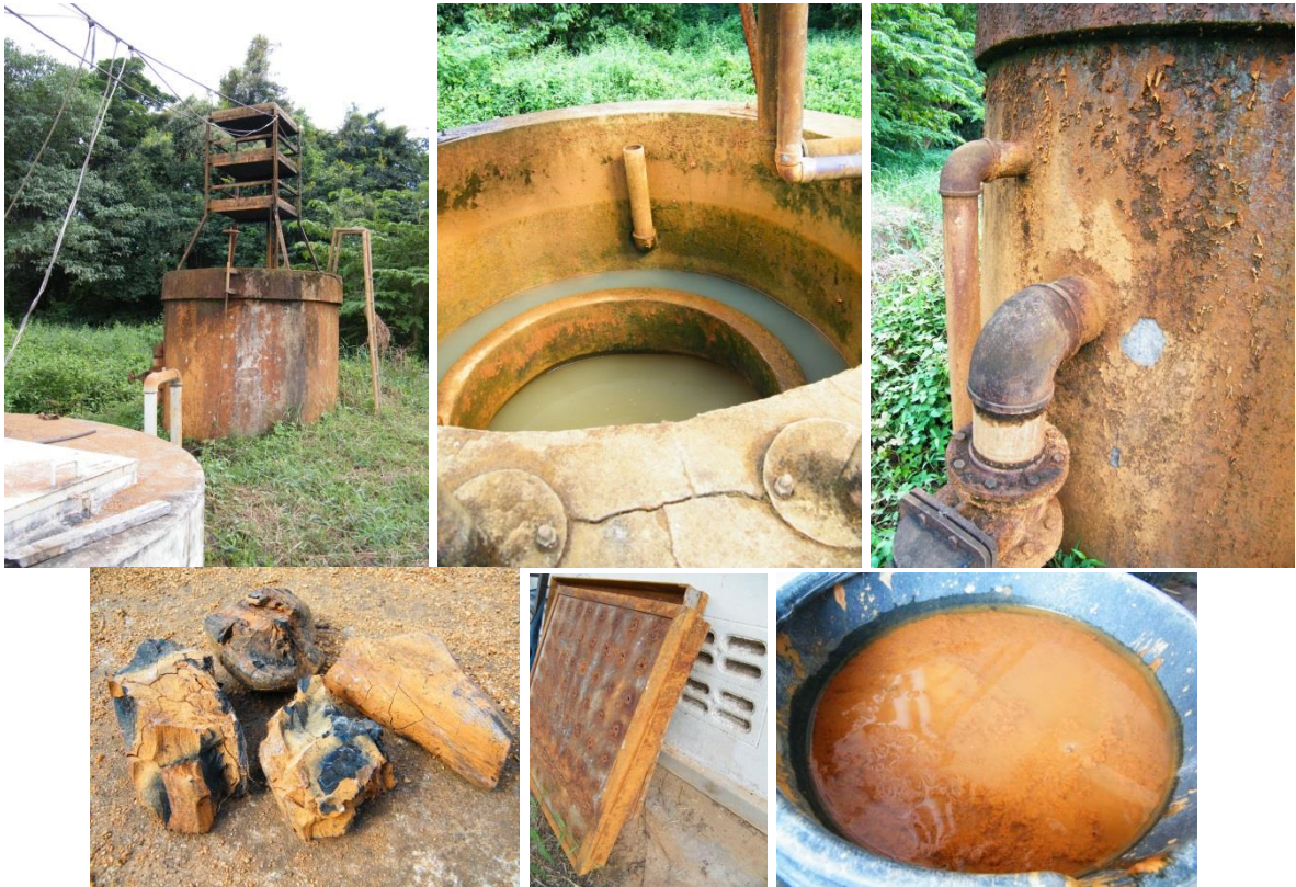
ภาพ 8-13 ระบบประปาบาดาลชนิดกรองด้วยทรายที่มีเหล็กออกไซด์ปนเปื้อน
