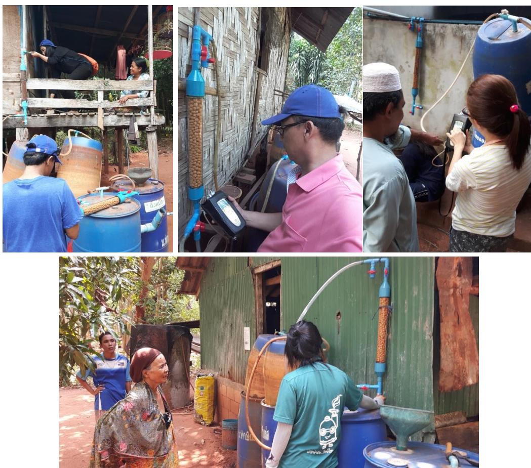
ภาพ 56-59 ติดตั้งชุดกำจัดก๊าซไฮโดรเจนซัลไฟด์ในพื้นที่ปฏิบัติการชาวประมงรายย่อย เกาะหมากน้อย
