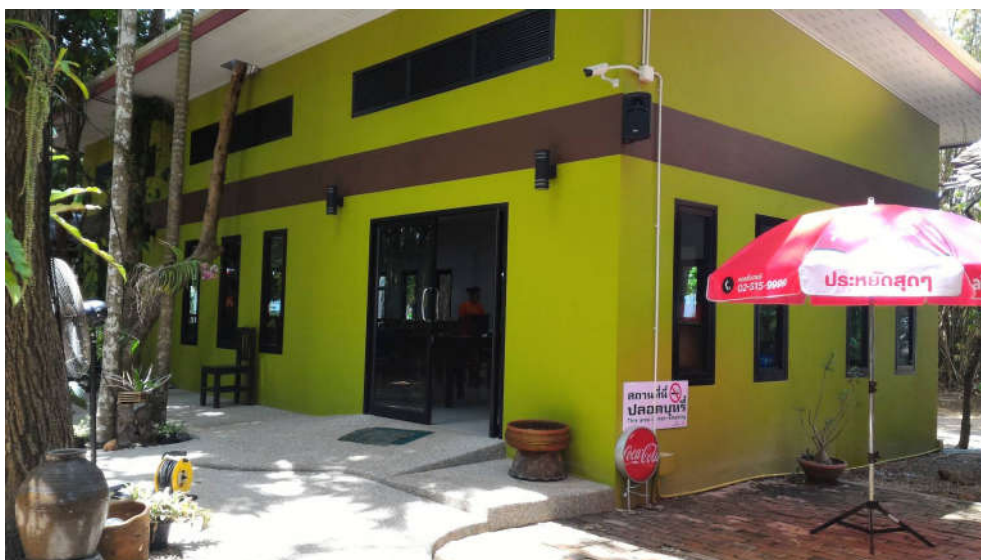
ภาพที่ 4.40 อาคารติดเครื่องปรับอากาศที่สร้างขึ้นใหม่
