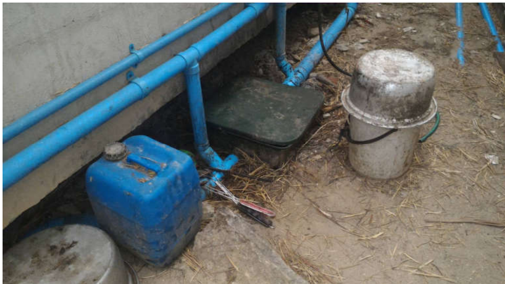
ภาพที่ 4.54 ถังดักไขมันของร้าน Samesame but Difference
