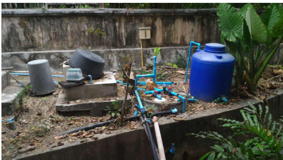
ภาพที่ 4.55 จุดที่นำน้ำดีผสมกับน้ำที่ผ่านการบำบัดเพื่อนำมารดน้ำต้นไม้
