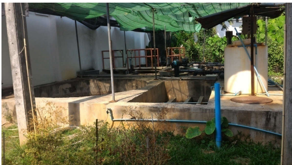
ภาพที่ 4.13 บ่อบำบัดน้ำเสียของโรงแรมอ่าวนางวิลลารีゾート
