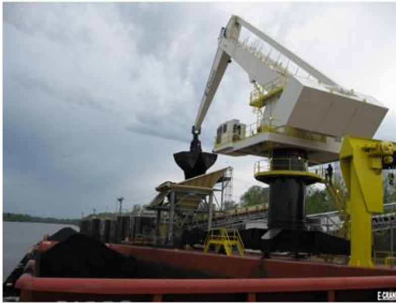
รูปที่ 6.4 เครนติดตั้งบนโป๊ะลอยน้ำทำหน้าที่ลำเลียงเชื้อเพลิงถ่านหินจากเรือสู่สายพาน
