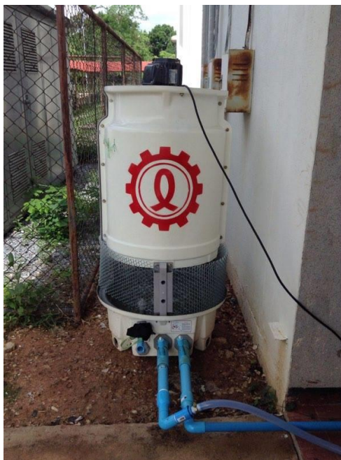
รูปที่ 97 การติดตั้ง cooling tower ใน DPAC
