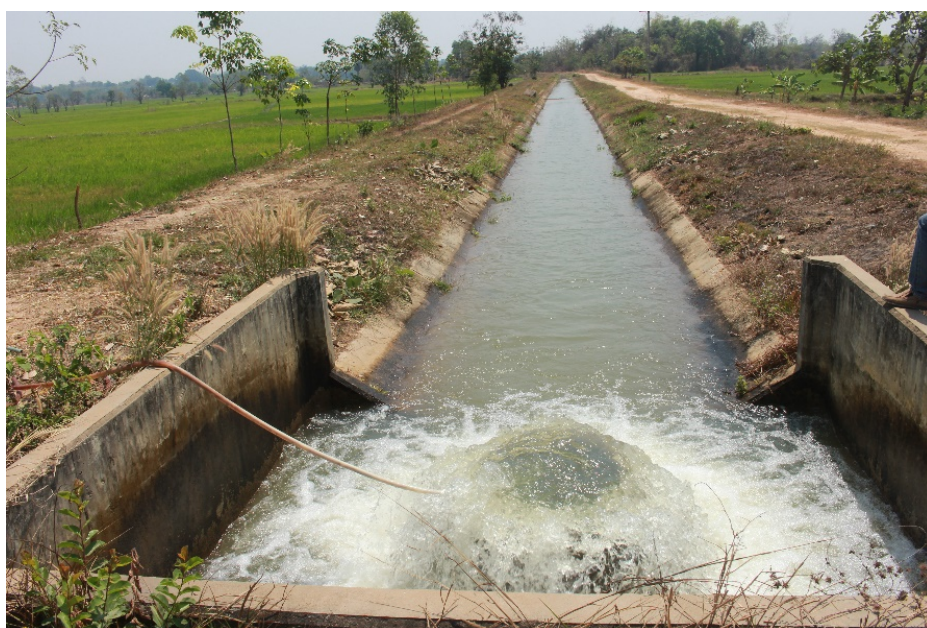
ภาพที่ 8 คลองชลประทานดาดคอนกรีตในโซนพื้นที่ 800 ไร่
