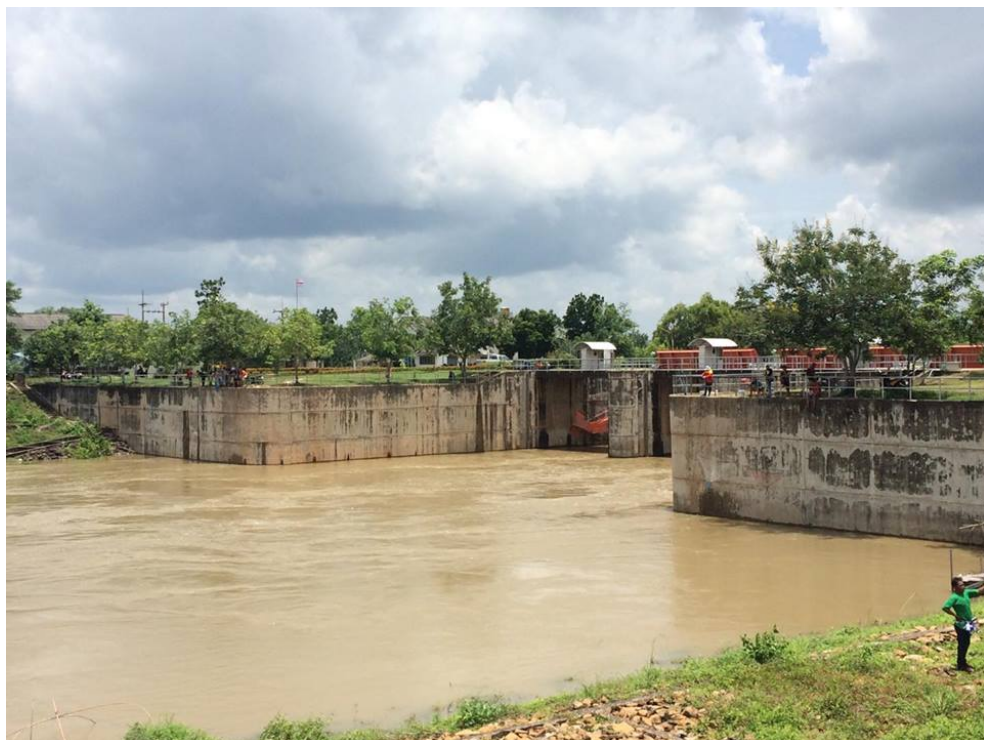
ด้านหลังประตูระบายน้ำเขื่อนลำเซบก
