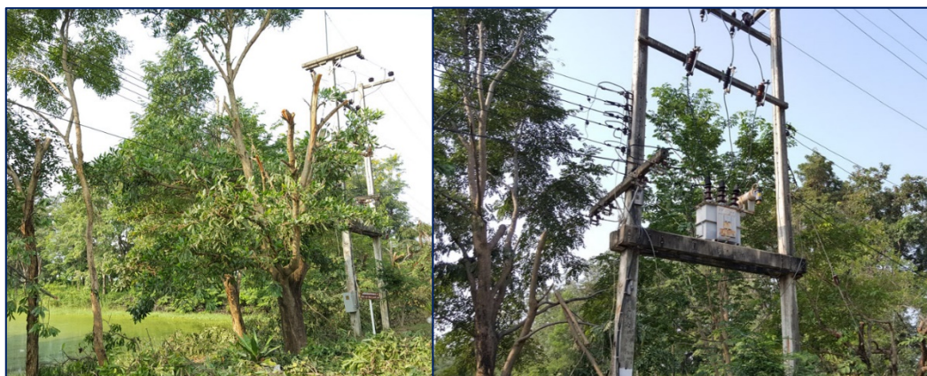
ภาพที่ 4-13 : การตัดกิ่งไม้ที่พาดผ่าน และเสียดสีกับสายส่งของโรงเรียน
