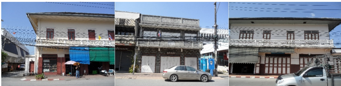
รูปที่ 4.17 เรือนร้านค้าแบบตึกแถวสองชั้นคอนกรีตเสริมเหล็ก
