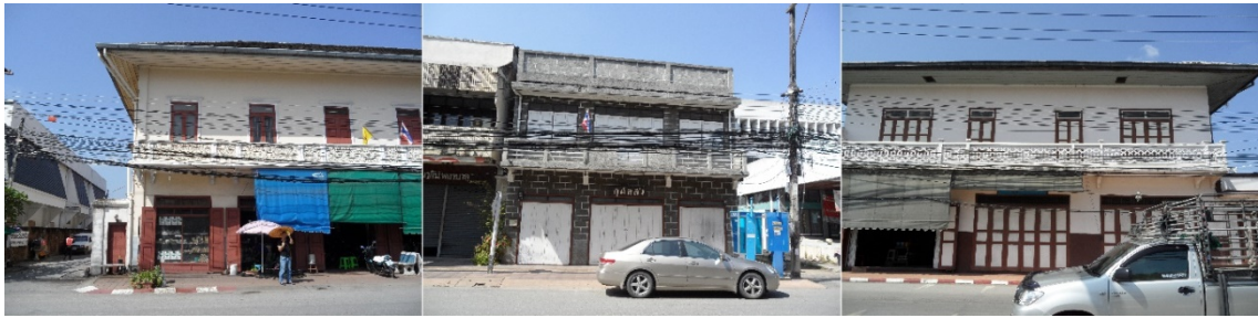
รูปที่ 2.35 เรือนร้านค้าแบบตึกแถวสองชั้นคอนกรีตเสริมเหล็ก
