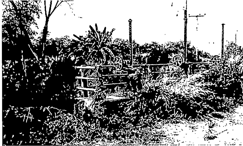
รูปที่ ค.14 อาคารอัดน้ำกลางคลองวังหมัน ขป.ขนาดเล็ก (ต.สะพานหิน)
