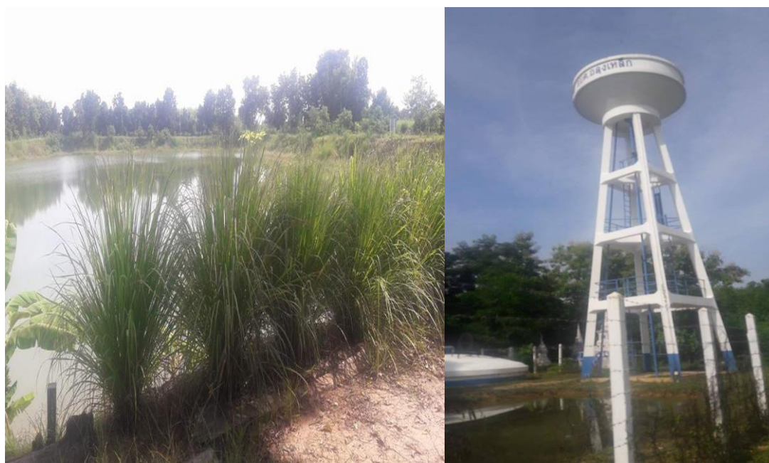
ภาพที่ ๓.๓๕-๓๖ สระหลวงและ ระบบประปาชุมชน
