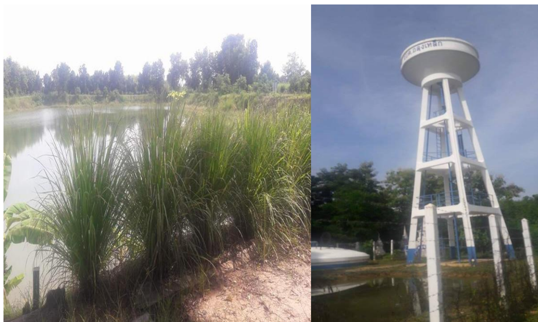
ภาพที่ ๕.๖-๗ สระหลวงและ ระบบประปาชุมชน
