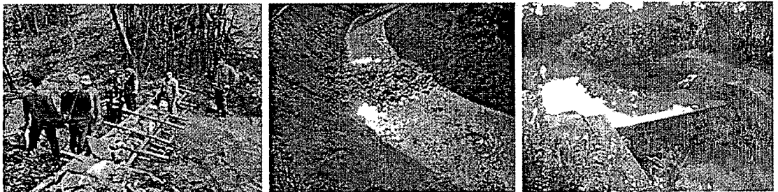
รูปที่ 15. ฝายชะลอน้ำที่สร้างด้วยไม้ไผ่เป็นรั้วหิน ฝายชะลอน้ำที่ใช้หินเรียง และฝายชะลอน้ำที่ใช้คอนกรีต
