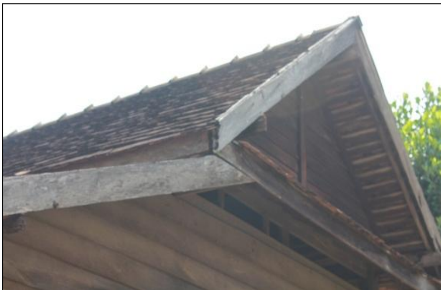
ภาพที่ 13 ลักษณะหลังคาที่มุงด้วยดินขอ มีความคงทนกว่าการมุงด้วยหญ้าคาหรือใบตองตึง
