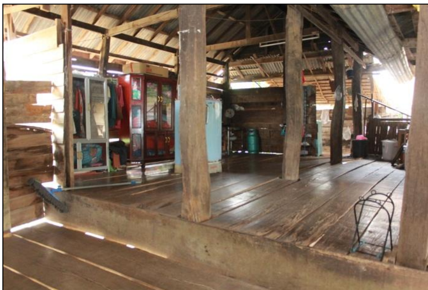
ภาพที่ 10 สภาพภายในบ้านที่ใช้ไม้แผ่นทำเป็นพื้น มีการแบ่งพื้นที่ตามลักษณะการใช้งาน
