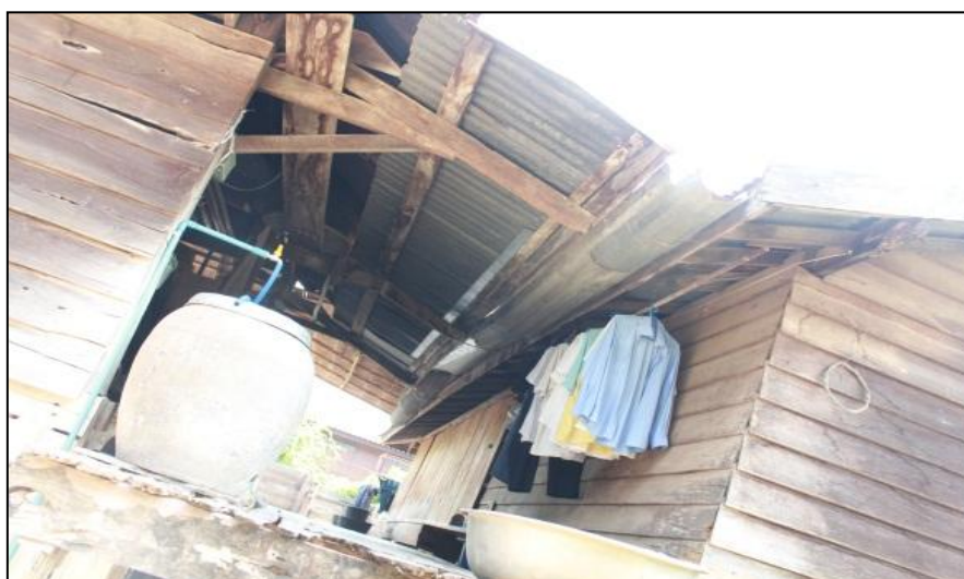
ภาพที่ 12 หลังคาบ้านที่เชื่อมต่อห้องที่แยกส่วน มีอ่าง (ราง) น้ำไว้รองรับน้ำฝน
