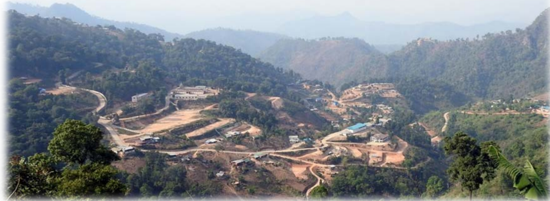
ดอยไตแลง : การก่อสร้างบ้านเรือน และโครงสร้างพื้นฐาน
