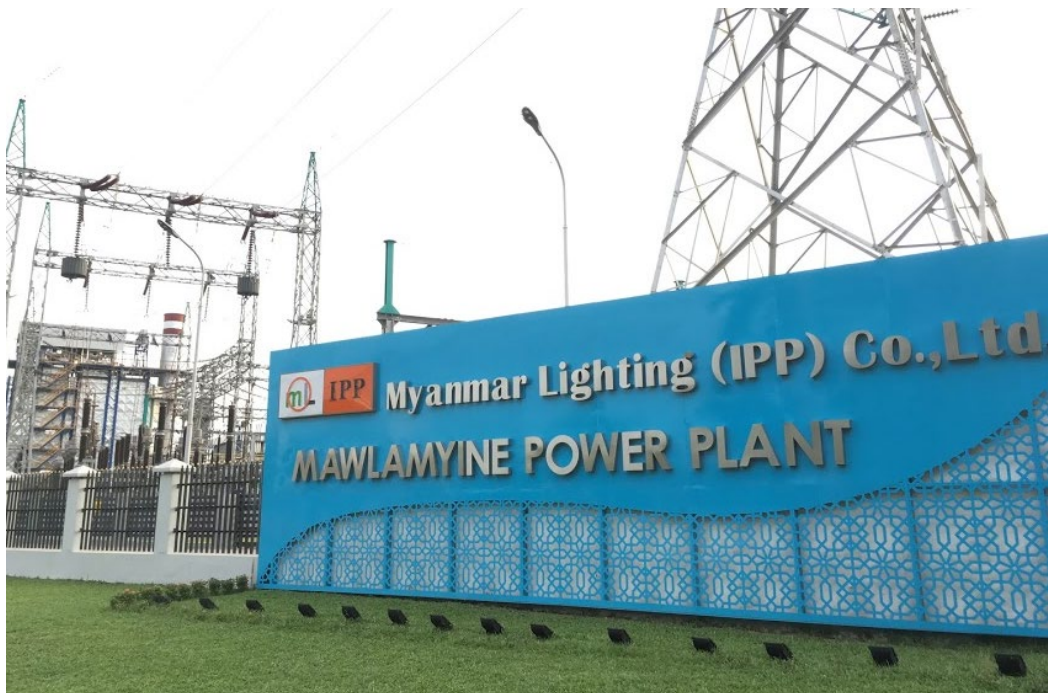
รูปที่ 26 โรงไฟฟ้าขนาด 230 MW ในเมืองเมะล่าย รัฐมอญ
