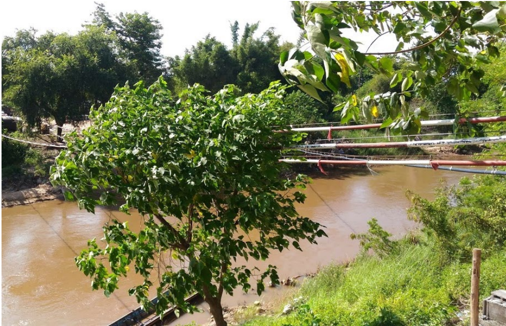
รูปที่ 20 ท่อส่งน้ำมันส่งน้ำมันจากที่ 21 ข้ามไปยังฝั่งเมียนมาเหนือแม่น้ำเมย
