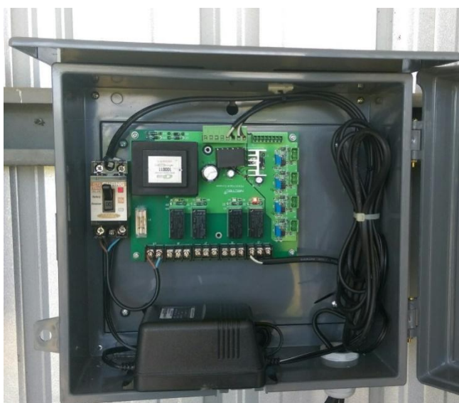
ภาพที่ 26 แสดงการติดตั้งบอร์ด Isolated Relay
