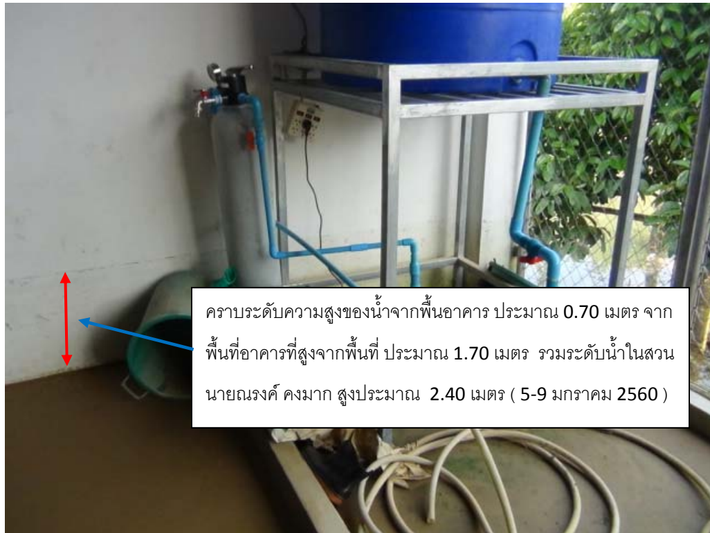
ภาพที่ 12 : ตรวจร่องรอยของระดับน้ำท่วมบนอาคารแปรรูปผลไม้ ซึ่งมีพื้นอาคารสูงจากพื้นสวน ประมาณ 1.70 เมตร
