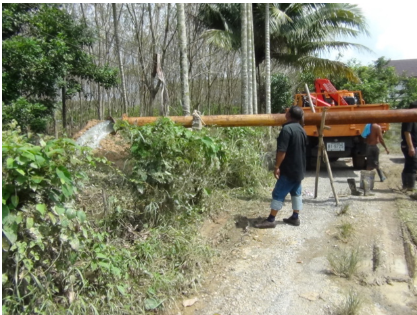
ภาพที่ 17 : สำนักงานชลประทานจังหวัดนครศรีธรรมราช นำเครื่องสูบน้ำขนาด 6 นิ้ว เข้ามาช่วยสูบน้ำออกจากแปลง สวนเงาะของสมาชิกวิสาหกิจชุมชน บ้านท่าเรือ หมู่ที่ 3 ตำบลท่าประจะ อำเภอลำพูน ( 12มกราคม 2560 ) โดยการประสานงานของสำนักงานเกษตรอำเภอลำพูน และสำนักงานโครงการพัฒนาลุ่มน้ำปากพนังตอนบน อำเภอลำพูน
