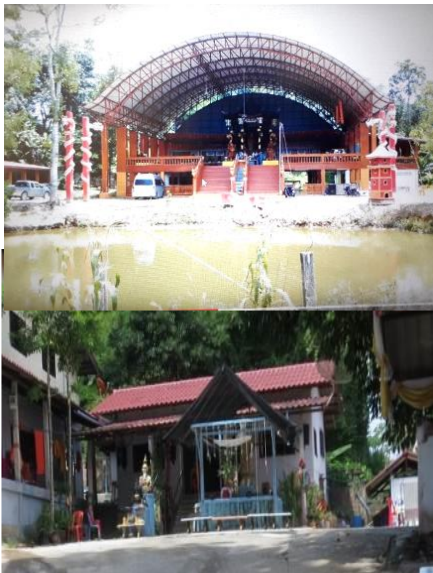
ภาพที่ 4.92 รูปแบบสถาปัตยกรรมและภูมิทัศน์ภายในสำนักสงฆ์จันรัตนาราม
