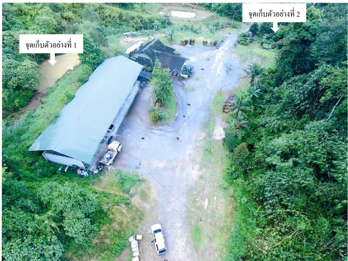
รูปที่ 4.24 จุดเก็บตัวอย่างน้ำบริเวณพื้นที่โครงการ
