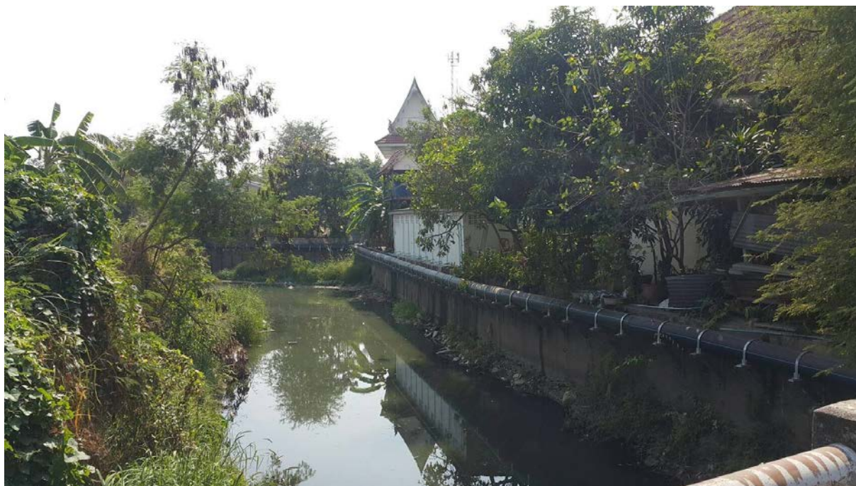
รูปที่ 4.34 ระบบรวบรวมน้ำเสียที่ก่อสร้างเลียบบคลองเดิม เทศบาลเมืองพุนนิกม
