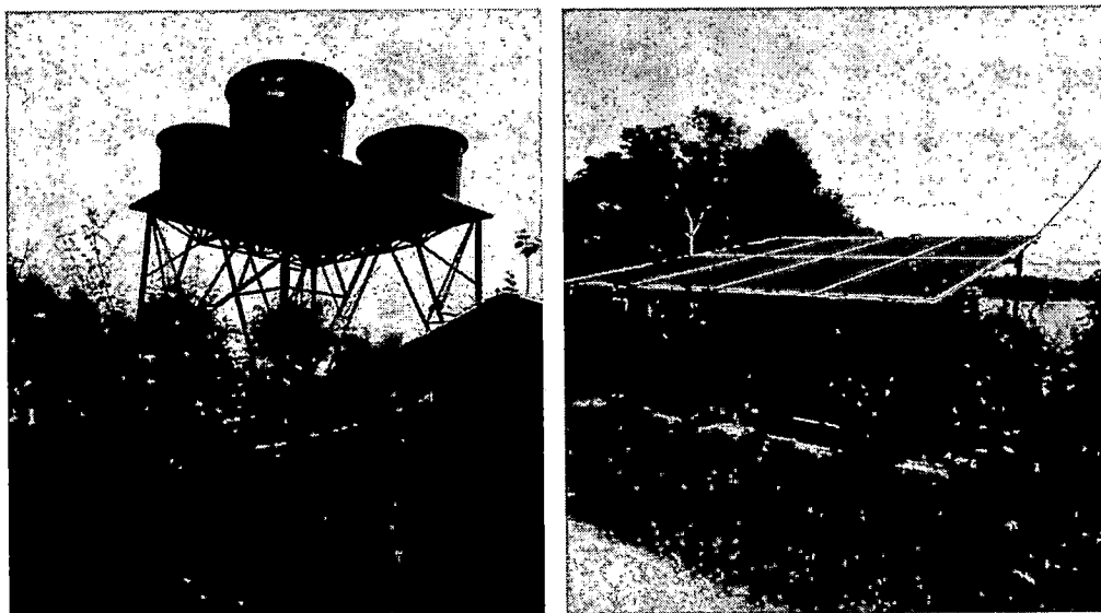
ภาพที่ 51 ระบบสูบน้ำเพื่อการเกษตรด้วยระบบโซล่าเซลล์น้ำผิวดินบ้านเจริญสุข
