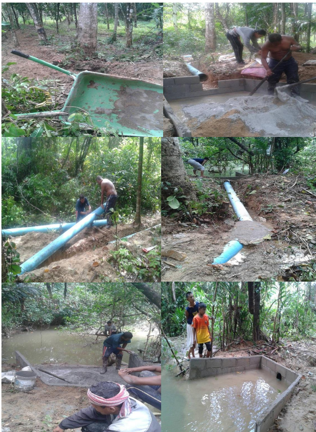
ภาพที่ 43ชาวบ้านบ้านต้นไม้สูงช่วยกันทำท่อส่งน้ำสำหรับการแก้ปัญหาการขาดแคลนน้ำทำนาเมื่อ วันที่ 10 - 20 กุมภาพันธ์ 2561
