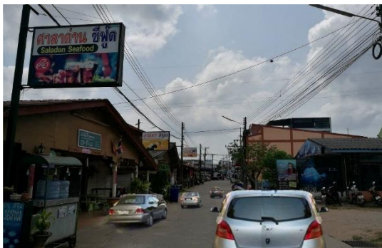
(ก่อนการปรับปรุงภูมิทัศน์)
