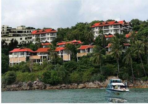
(ก่อนการปรับปรุงภูมิทัศน์)
