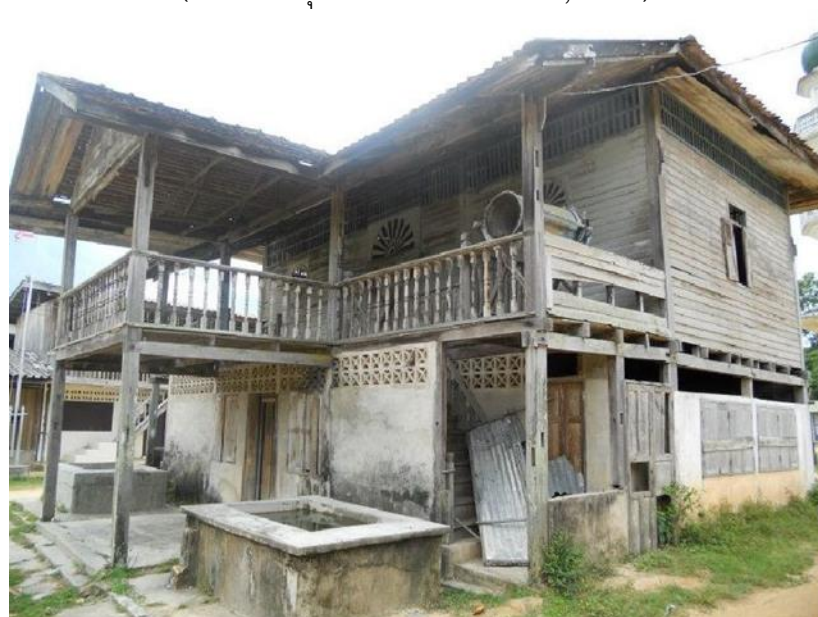
รูปภาพที่ 12 บ้านมลายูหลังคาทรงเมเลห์ (Meleh) หรือหลังคาจั่ว
