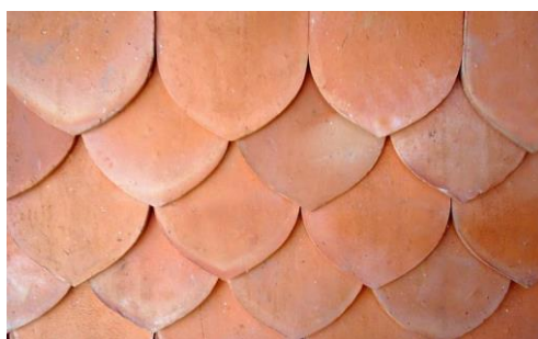
ภาพที่ 1.6 การมุงหลังคาแบบกระเบื้องปูหลังคาชั้นเดียว
