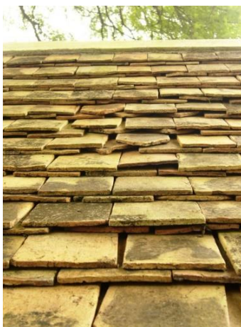
ภาพที่ 1.8 รูปแบบการมุงกระเบื้องสองชั้น
