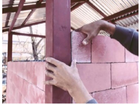
การวางคอนกรีตบล็อก
