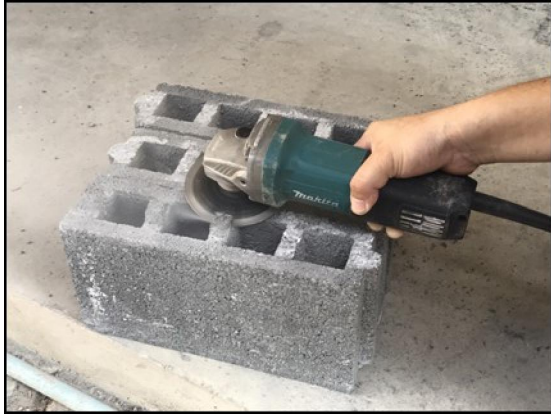
การเจียรด้านบนคอนกรีตบล็อกให้เรียบ
