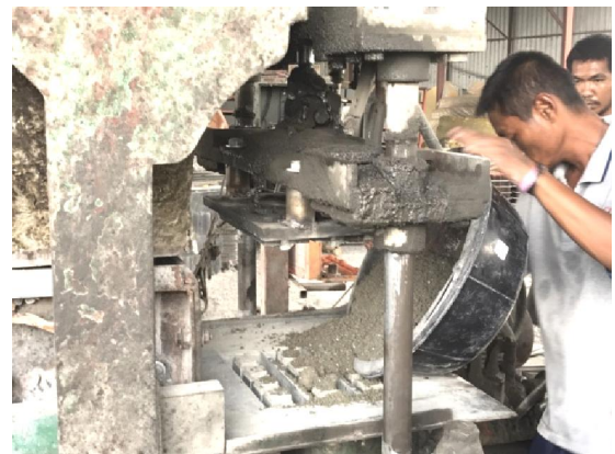
เทส่วนผสมลงในแบบหล่อคอนกรีตบล็อก
