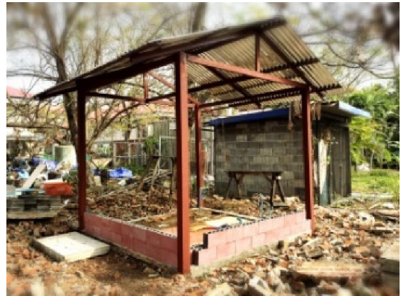
ทำโครงสร้างห้องทดสอบอุณหภูมิ
