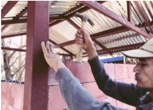
การตอกคอนกรีตบล็อก
