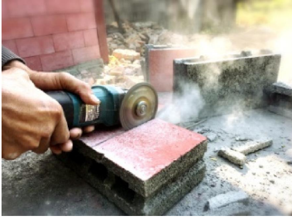
การตัดคอนกรีตบล็อก
