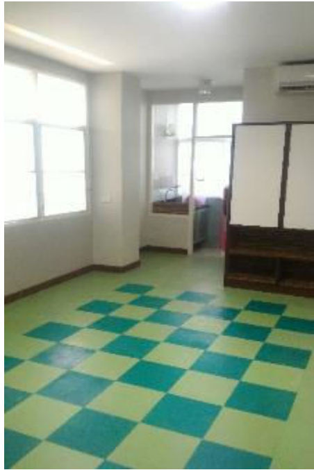
รูปที่ 4.5 การปูแผ่นยางปูพื้นสำหรับห้องกายภาพบำบัด สถานที่โรงพยาบาลวังจันทร์ ตำบลชุมแสง อำเภอวังจันทร์ จังหวัดระยอง
