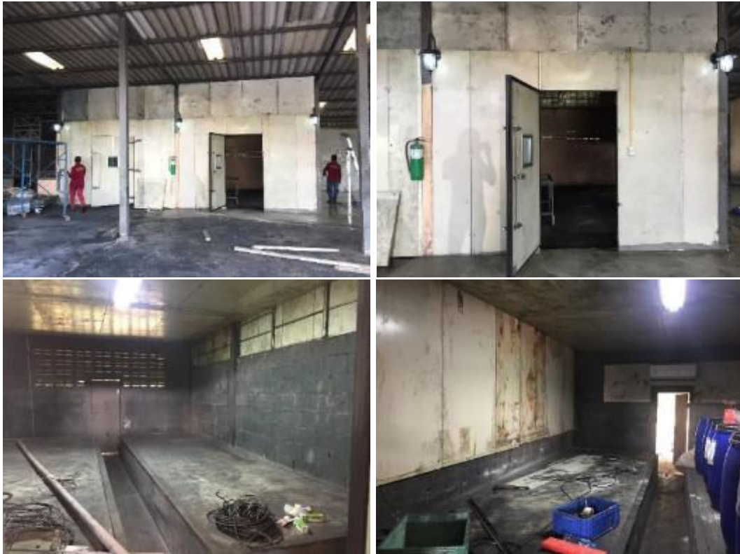
รูปที่ 4.30 ห้องเก็บสารเคมีและวัตถุดิบ และห้องเก็บยางคอมพาวด์ ที่ต่อเติมขึ้นใหม่และอยู่ในระหว่างการปรับปรุงพื้นที่
