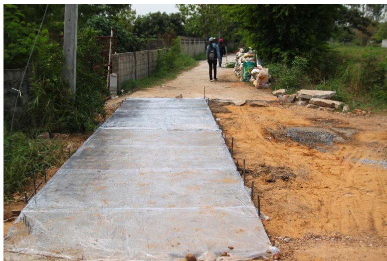
รูปที่ 4.34 ปิดผิวจีโอโพลิเมอร์คอนกรีตผสมน้ำยางพาราด้วยพลาสติกใสป้องกันการสูญเสียความชื้น
