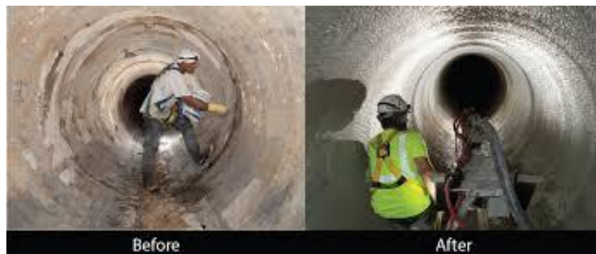
รูปที่ 2.5 การใช้งานจีโอโพลิเมอร์แบบต่าง ( http://infrastructure.milliken.com )
