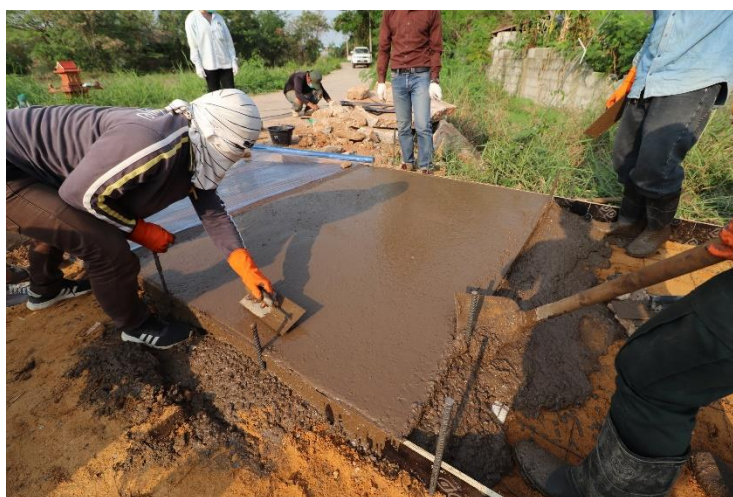
รูปที่ 4.33 จีโอโพลิเมอร์คอนกรีตผสมน้ำยางพารามีลักษณะความชื้นเหลือสูงเข้าแบบได้
