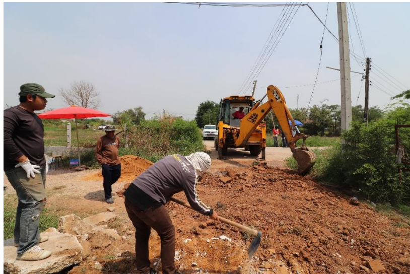
รูปที่ 4.31 พื้นดินเดิมมีความแข็งสูงจึงต้องใช้เครื่องจักรช่วยในการปรับระดับ
