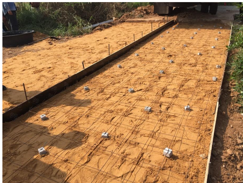
รูปที่ 4.32 ลักษณะการเตรียมพื้นและแบบก่อนการดำเนินการเทจีโอโพลิเมอร์คอนกรีต
