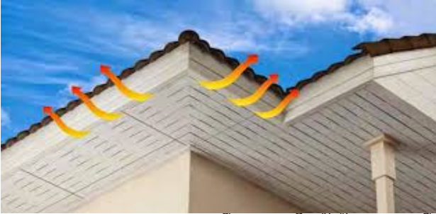
รูปที่ 2 การติดตั้งฝ้าเพดานเพื่อช่วยระบายความร้อนภายใต้หลังคา
