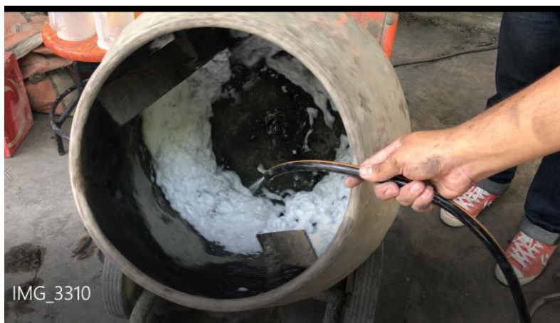
รูปที่ 3.14 การฉีดโฟมเหลวลงในมอร์ตาร์
