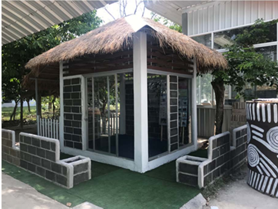
รูปที่ 4.10 การนำวัสดุจี้ไปใช้ในงานก่อสร้างจริง
