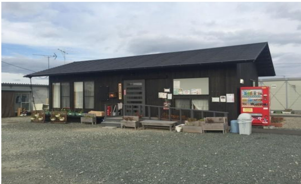
รูปภาพที่ 30 อาคารซึ่งจัดเป็นพื้นที่สาธารณะภายในบริเวณ Techno Temporary Housing, Mashiki Town
