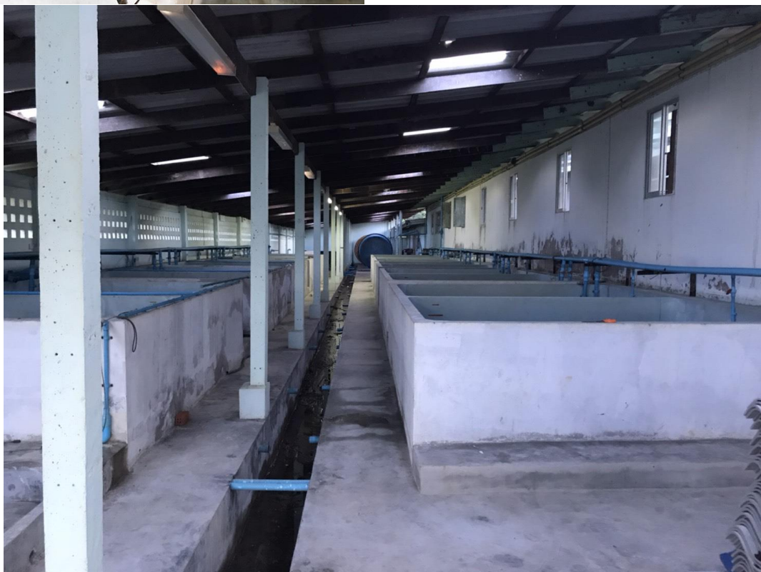
รูปที่ 36 บ่อคอนกรีตสำหรับขุนปูทะเลและการขุนปูทะเลในบ่อ
