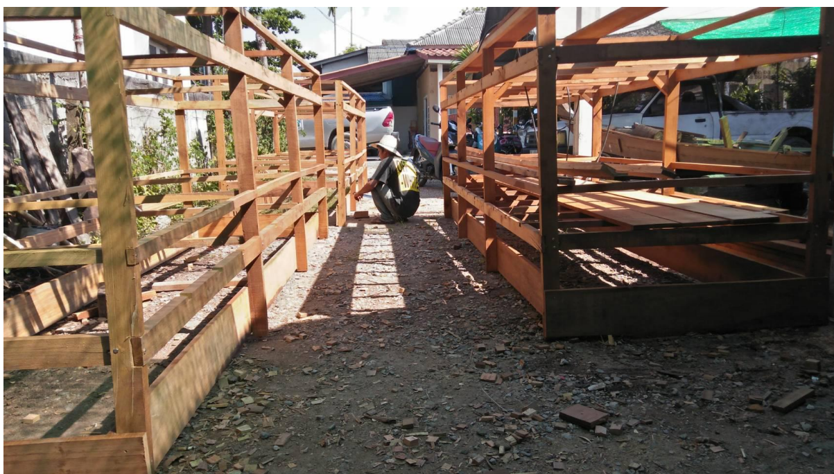
รูปที่ 31 โครงสร้างคอนโดระบบน้ำหมุนเวียนสำหรับการขุนปูทะเล (บน) คอนโดที่สร้างด้วยโครงการสร้างเหล็ก (ล่าง) คอนโดที่สร้างด้วยโครงสร้างไม้เนื้อแข็ง
