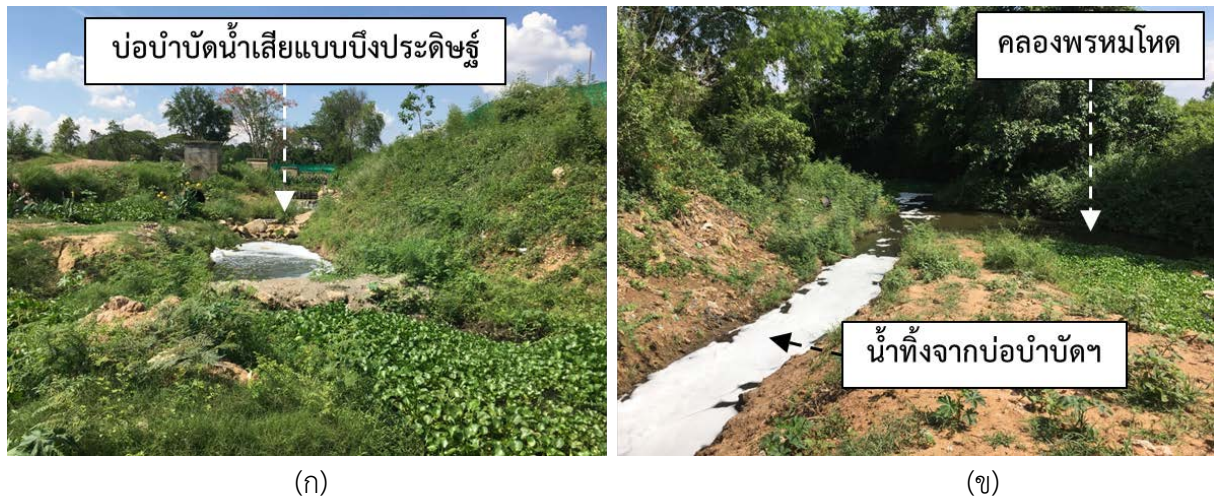
ภาพที่ 4.17 ลักษณะของ (ก) บ่อบำบัดน้ำเสียรวมของเทศบาลเมืองอรัญประเทศและ (ข) จุดที่น้ำทิ้งบ่อบำบัดฯ ไหลลงสู่คลองพรหมโหด
