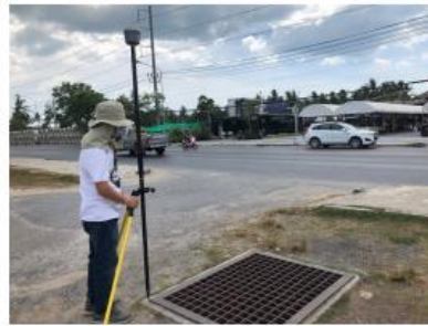
รูปที่ 4.6 แสดงการหาค่าพิกัดหมุดควบคุมภาคพื้นดิน (GCP) และหมุดตรวจสอบ (CP) โดยใช้เครื่องรับสัญญาณดาวเทียม GNSS
