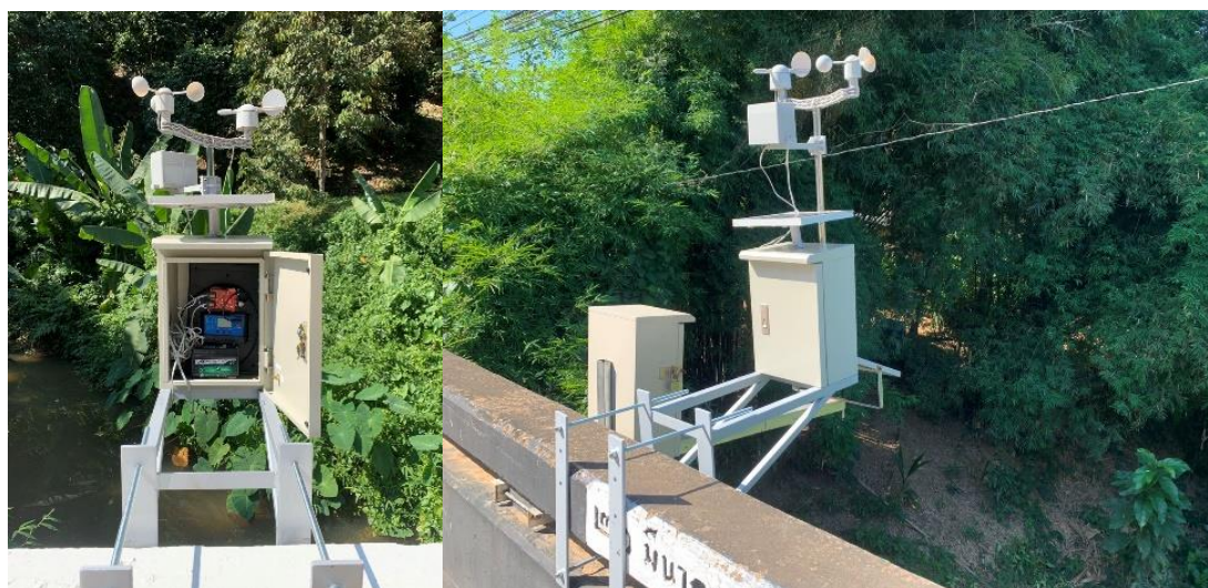
ภาพที่ 4.40 การติดตั้งอุปกรณ์ในพื้นที่บริเวณสะพานคลองนาโป่ง และสะพานเหือนลับแล หมู่ 4
