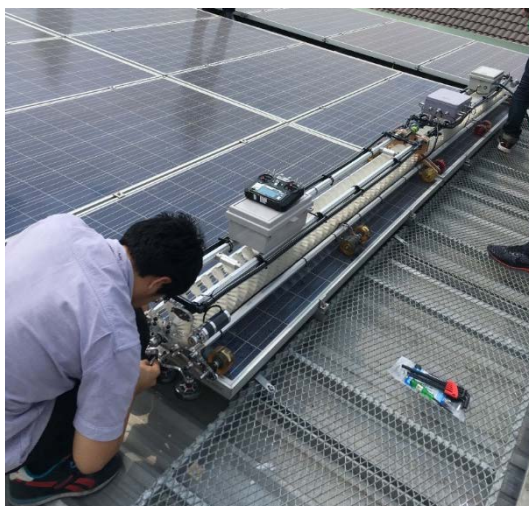
รูปที่ 3.37 การติดตั้งหุ่นยนต์ทำความสะอาดแผงเซลล์พลังงานแสงอาทิตย์โซลาร์รูฟท็อป
