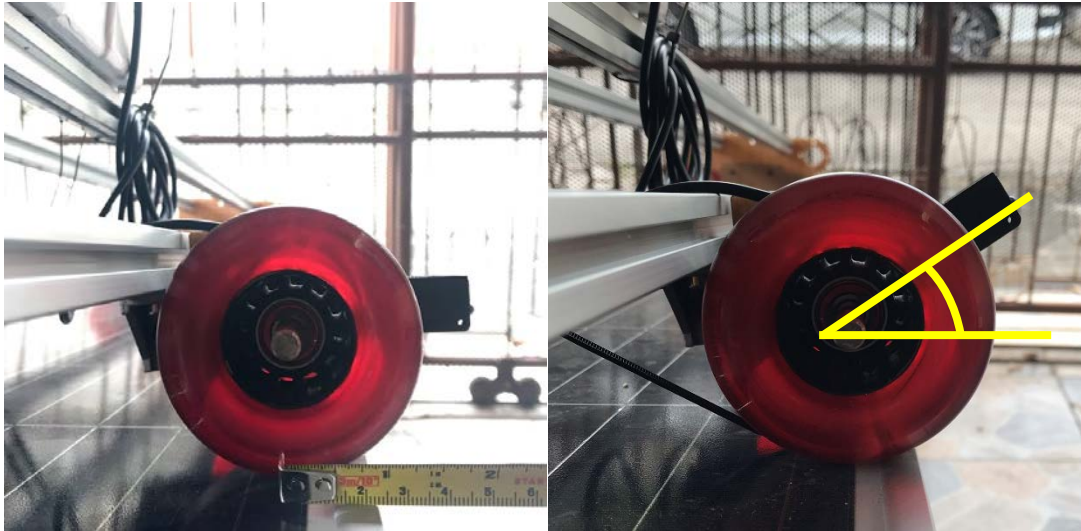
รูปที่ 3.31 แสดงรูปก่อนและหลังการปรับตำแหน่งการติดตั้งเซนเซอร์ Proximity
