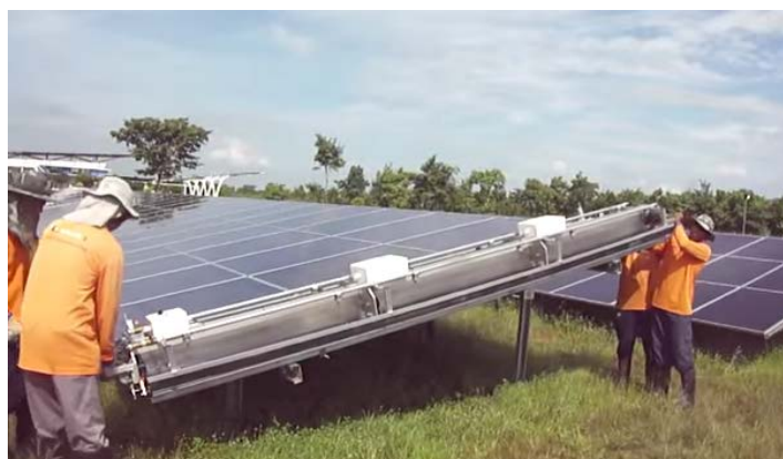
รูปที่ 2.10 วิธีการยกเครื่องเพื่อเคลื่อนย้ายไปยังแถวถัดไป
