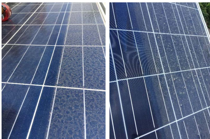
รูปที่ 3.44 การเปรียบเทียบลักษณะของฝุ่นหลังการทำความสะอาดเสร็จสิ้น (ด้านซ้าย) ทำความสะอาดแบบไม่ใช้น้ำ (ด้านขวา) ทำความสะอาดด้วยน้ำ
