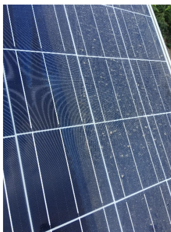
รูปที่ 3.43 ลักษณะของฝุ่นหลังการทำความสะอาดเสร็จสิ้น (ด้านซ้าย) ทำความสะอาดเสร็จแล้ว (ด้านขวา) ยังไม่ได้ทำความสะอาด
