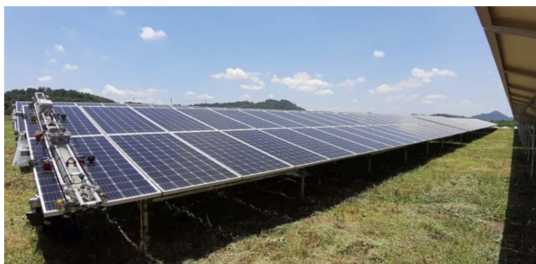
รูปที่ 3.53 การติดตั้งหุ่นยนต์ทำความสะอาดแผงเซลล์พลังงานแสงอาทิตย์
