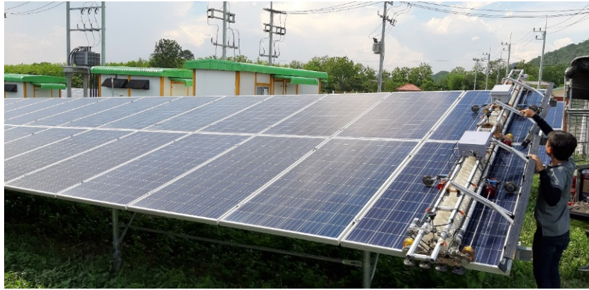
รูปที่ 3.57 แสดงการติดตั้งหุ่นยนต์ล้างแผงเซลล์พลังงานแสงอาทิตย์
