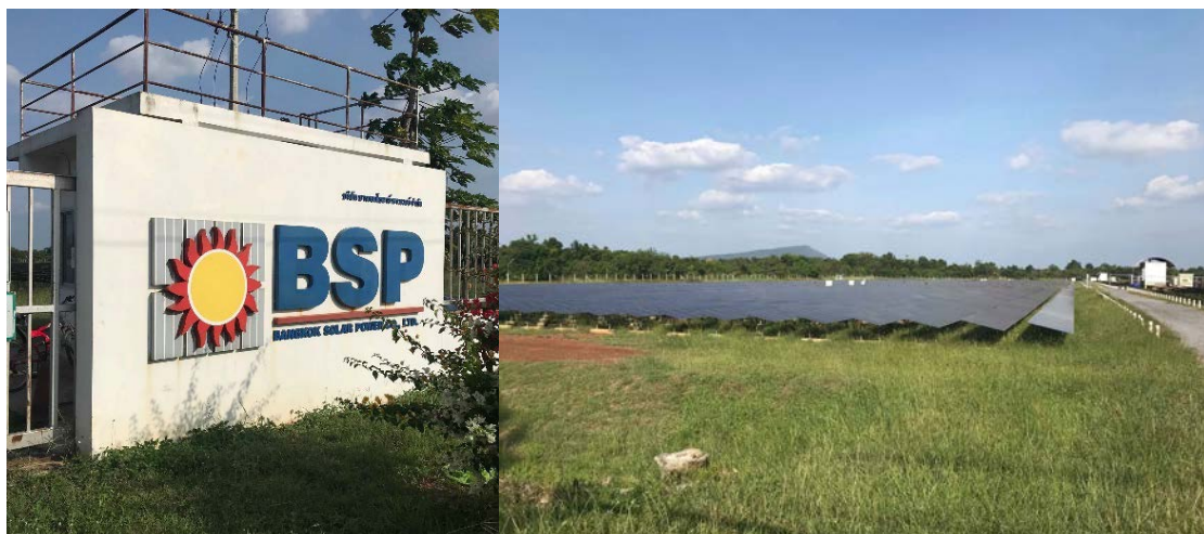
รูปที่ 3.10. แสดงโรงไฟฟ้าพลังงานแสงอาทิตย์ จ.ลพบุรี โครงการ 1
