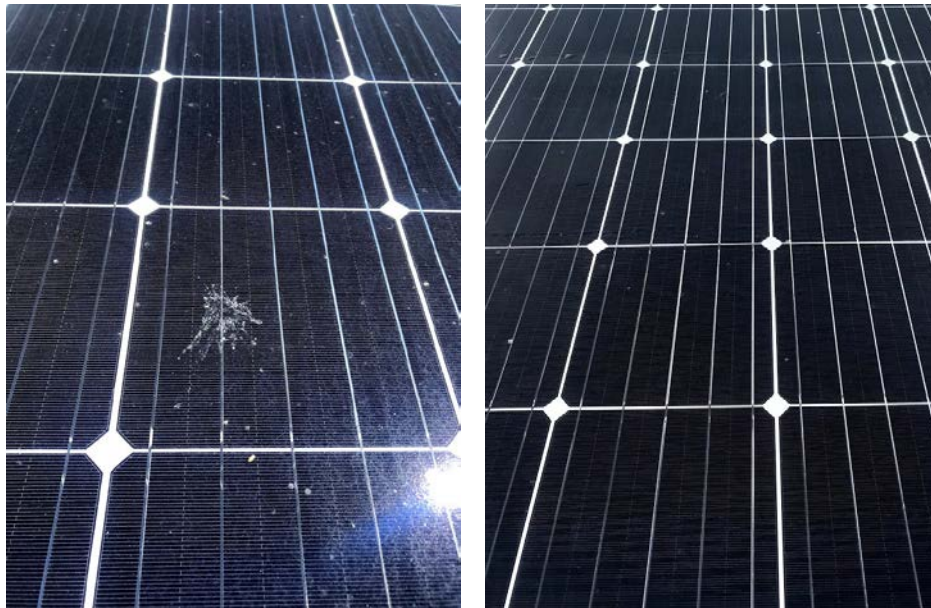
รูปที่ 3.54 การเปรียบเทียบลักษณะของฝุ่นหลังการทำความสะอาดเสร็จสิ้น (ด้านซ้าย) ยังไม่ได้ทำความสะอาด (ด้านขวา) ทำความสะอาดด้วยน้ำ (โครงการผลิตไฟฟ้าพลังงานแสงอาทิตย์แบบติดตั้งบนพื้นดิน)
