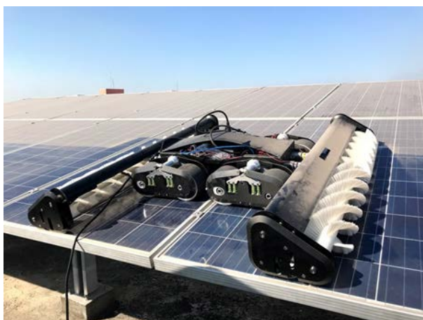
รูปที่ 4.54 การทดสอบการทำความสะอาดแผงเซลล์แสงอาทิตย์ของหุ่นยนต์ต้นแบบสำหรับทำความสะอาดแผงเซลล์แสงอาทิตย์ แบบบนหลังคา โดยใช้การประเมินผลด้วยสายตา
