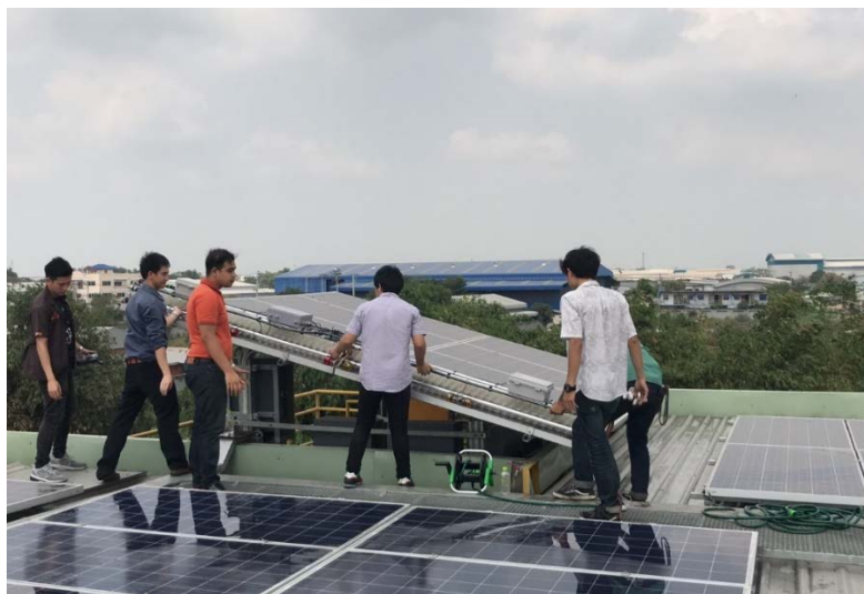
รูปที่ 3.36 การติดตั้งหุ่นยนต์ทำความสะอาดแผงเซลล์พลังงานแสงอาทิตย์โซลาร์ฟาร์มท่ามุ่ม 15 องศา
