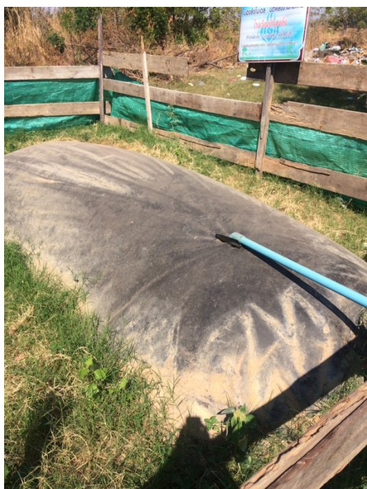
ภาพที่ 10 บ่อก๊าซชีวภาพ ขนาด 8 คิว และหัวแก๊ส
