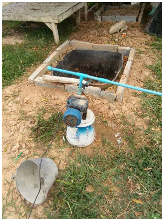
ภาพที่ 18 สภาพบ่อก๊าซขนาด 8 คิว ก่อนดำเนินการฟื้นฟูและปรับปรุง (ซ้าย) และการดำเนินการล้างบ่อโดยใช้ปั๊มดูดน้ำตะกอนออกจากบ่อ (ขวา)
