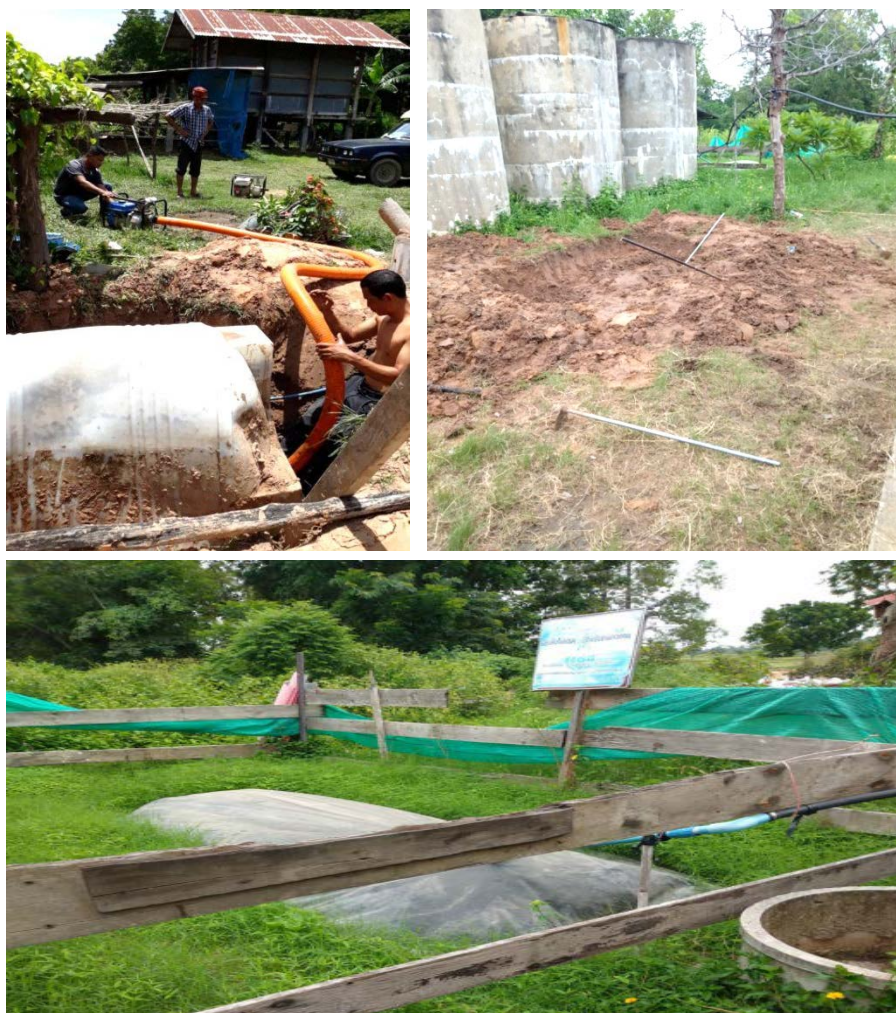
ภาพที่ 23 ทีมกำลังรื้อถอนบ่อก๊าซนายบุญมี สุขจิต เพื่อนำไปติดตั้งที่โรงเรียนบ้านดงเค็ง (บนซ้าย) พื้นที่ของโรงเรียนที่เตรียมติดตั้งบ่อก๊าซ 1.5 คิว (บนขวา) และบ่อก๊าซขนาด 8 คิว ที่ใช้งานปัจจุบันในโรงเรียน (ล่าง)
