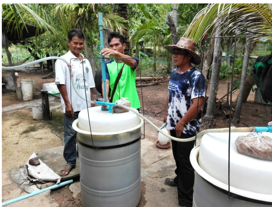
ภาพที่ 19 การถ่วงน้ำหนักถังเก็บก๊าซ โดยใช้ถุงทราย
