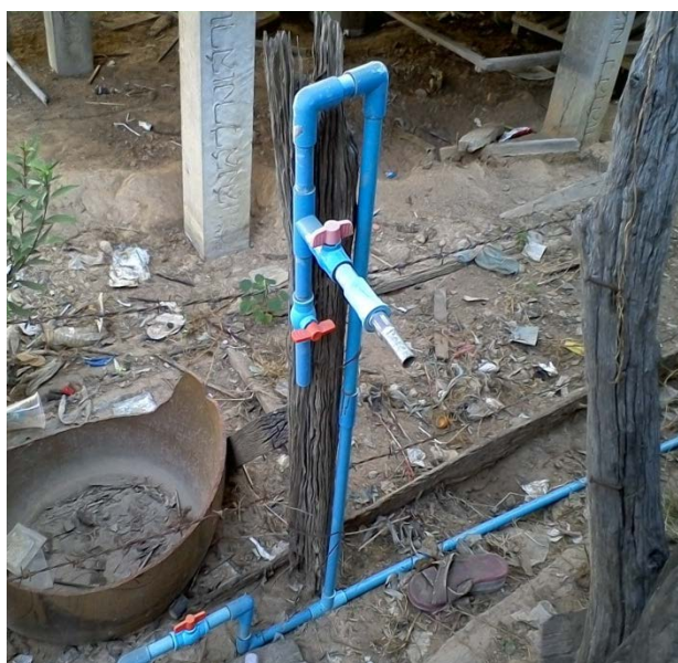
ภาพที่ 13 ท่อส่งแก๊สและผู้ใช้ก๊าซจากบ่อก๊าซชีวภาพ ขนาด 200 คิว
