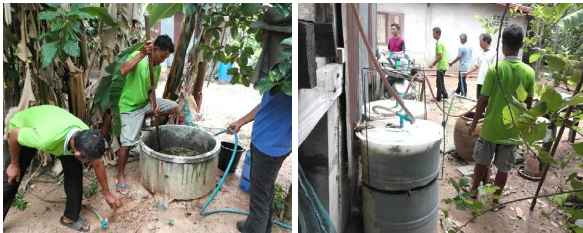
ภาพที่ 20 การปรับปรุงและฟื้นฟูสภาพการใช้งานบ่อก๊าซชีวภาพ 1.5 คิว นายแจ้ อินทร์สำราญ บ้านหลวงอุดม
