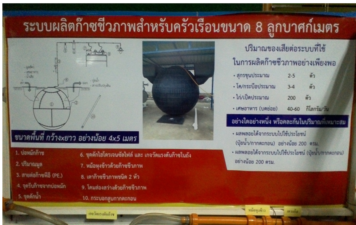
ภาพที่ 11 ระบบผลิตก๊าซชีวภาพ ขนาด 8 คิว
