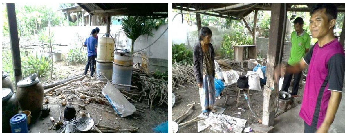
ภาพที่ 21 การปรับปรุงและฟื้นฟูสภาพการใช้งานบ่อก๊าซชีวภาพ 1.5 คิว บ้านนางหุ่ย ฉิมรัมย์
