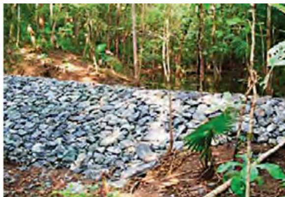
ภาพที่ 2.2 รูปแบบฝายแบบเรียงด้วยหินค่อนข้างถาวร
