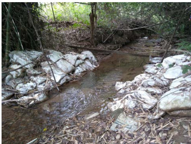
ภาพที่ 4.13 ฝายกระสอบที่พบในลำห้วย
