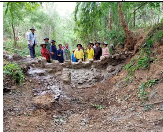
สร้างฝายดักตะกอนพื้นที่บ้านหัวฝาย หมู่ที่ 3
