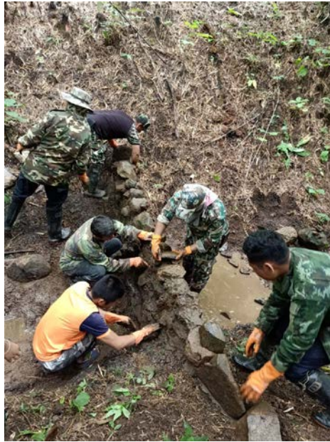
ภาพที่ 4.28 การสร้างฝายดักตะกอนบ้านทุ่งผึ้ง หมู่ที่ 4
