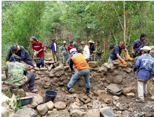
ภาพที่ 4.27 การสร้างฝายดักตะกอนบ้านหัวฝาย หมู่ที่ 3
