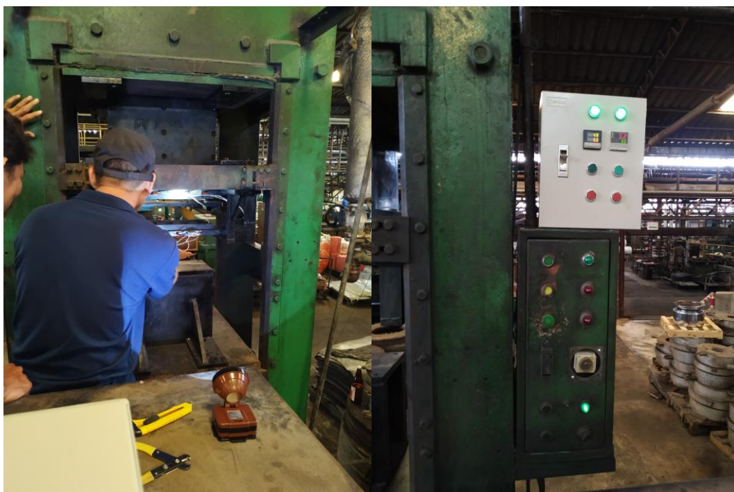
ภาพที่ 42 การติดตั้งฮีตเตอร์และต่อไฟเข้ากับระบบ
