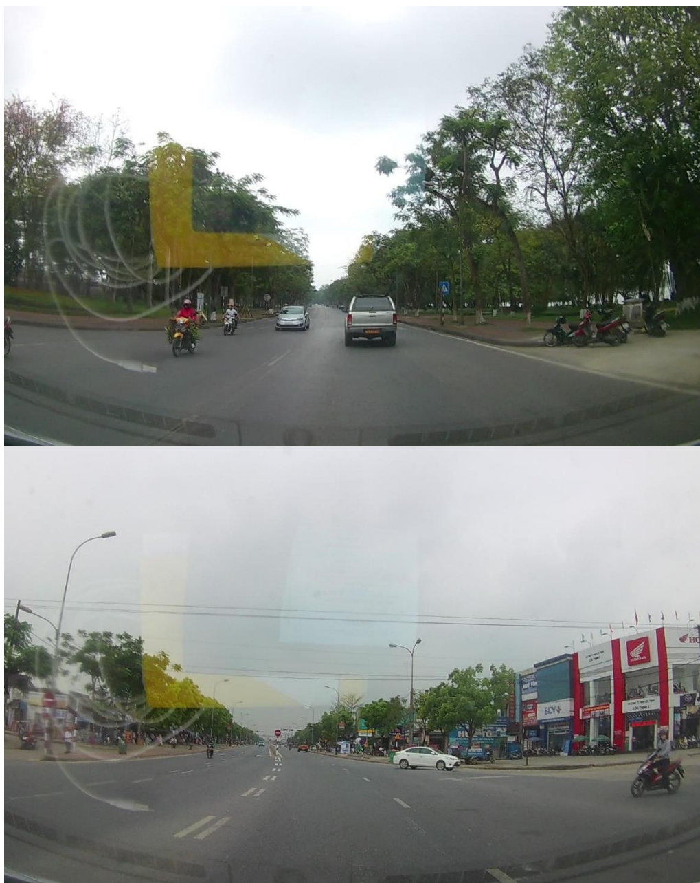
รูปที่ 3-22 สภาพถนนบนเส้นทาง R9 ที่พาดผ่านเมืองเทือ เทียน-ฮิว (เว้) สาธารณรัฐสังคมนิยมเวียดนาม
