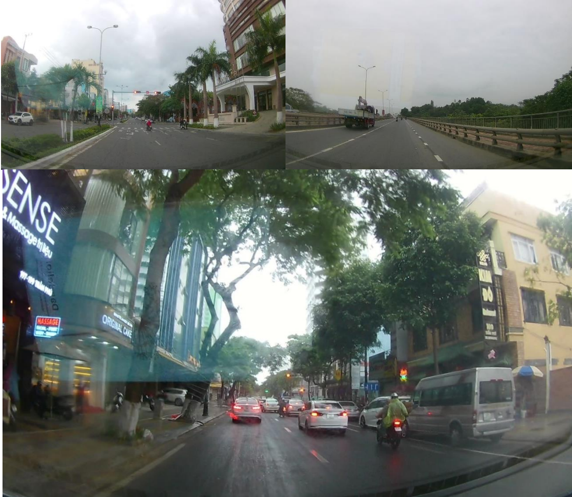
รูปที่ 3-24 สภาพถนนบนเส้นทาง R9 ที่พาดผ่านเทศบาลนครดานัง สาธารณรัฐสังคมนิยมเวียดนาม
