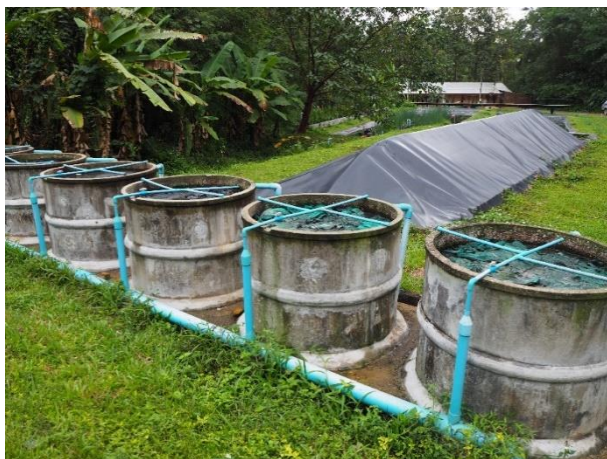
รูปที่ 4.5 แสดงระบบบำบัดน้ำเสียสีย้อม (ระบบบำบัดชีวภาพด้วยจุลินทรีย์ (ซ่าย) และบ่อกักน้ำหลังการบำบัด (ขวา)) จากส่วนงานมือของโครงการมูลนิธิแม่ฟ้าหลวง ดอยตุง ในพระบรมราชูปถัมภ์
