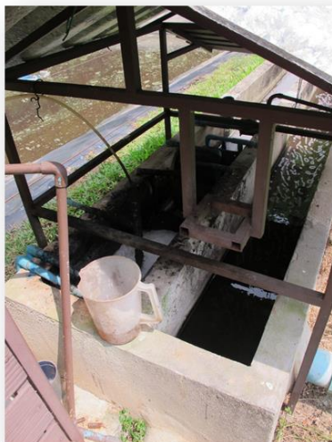
จุดเก็บน้ำ บ่อพักน้ำทิ้งก่อนนำเข้าระบบบำบัดของโรงงานฯ
