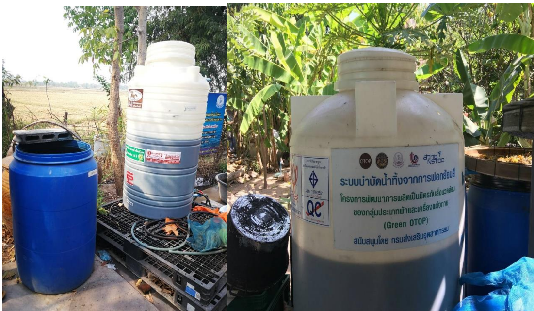
รูปที่ 4.3 แสดงระบบบำบัดน้ำเสียที่ย้อมสีที่ทางสำนักงานอุตสาหกรรมจังหวัดและกรมส่งเสริมอุตสาหกรรม จัดหาให้
