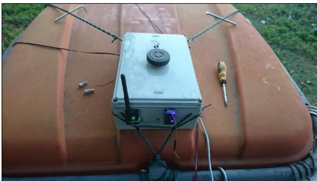
ภาพที่ 78 การติดตั้งอุปกรณ์ควบคุมที่ตัวรถ
