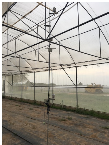
รูปที่ 20 การติดตั้ง Weather station และระบบตรวจวัดและเก็บข้อมูลต่างๆภายในโรงเรือน
