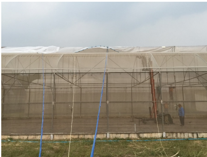
รูปที่ 15 คลุมหลังคาด้วยพลาสติกเพื่อป้องกันฝน
