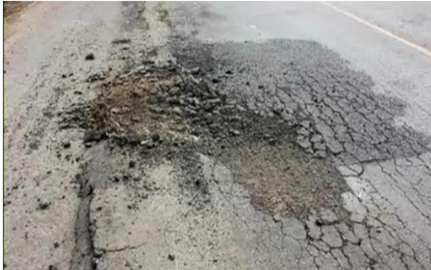
รูปที่ 5.2-3 สภาพถนนยุบตัวเป็นหลุมบ่อสาเหตุจากรถบรรทุกอ้อย
