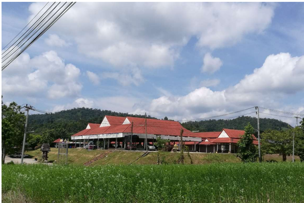
ภาพที่ 34 อาคารตลาด ณ จุดผ่านแดนถาวรภูค้อ จังหวัดอุดรธานี (ที่มา: คณะผู้วิจัย, 2561.)
