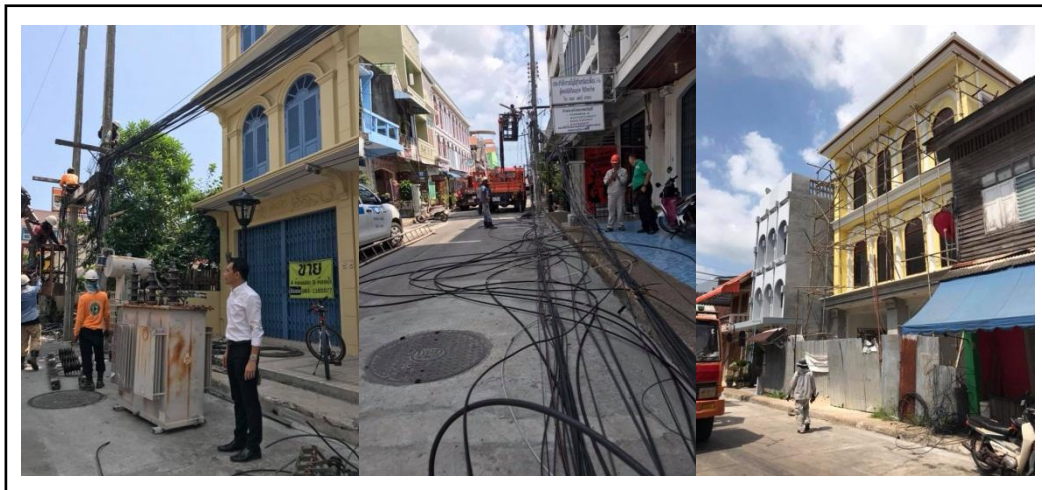
ภาพที่ 4.29 แสดงการปรับปรุงระบบสายไฟฟ้าลงดิน ในพื้นที่เมืองเก่าสงขลา ที่มา : กิมหยงดอทคอม (2562)
