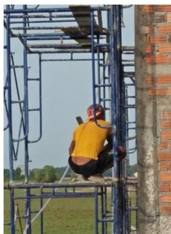
รูปที่ 6.7 การแต่งกายขณะทำงานของแรงงานมอญก่อสร้างขณะทำงาน
