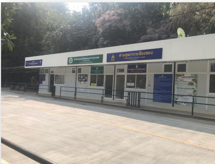
รูปภาพที่ 4 ภาพหน่วยงานบริเวณด้านบ้านฮวกจากการลงพื้นที่ติดตามความเคลื่อนไหว
